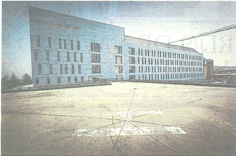
Imagen del helipuerto del Hospital Santa Bárbara de la ciudad de Soria. / EUGENIO GUTIÉRREZ
